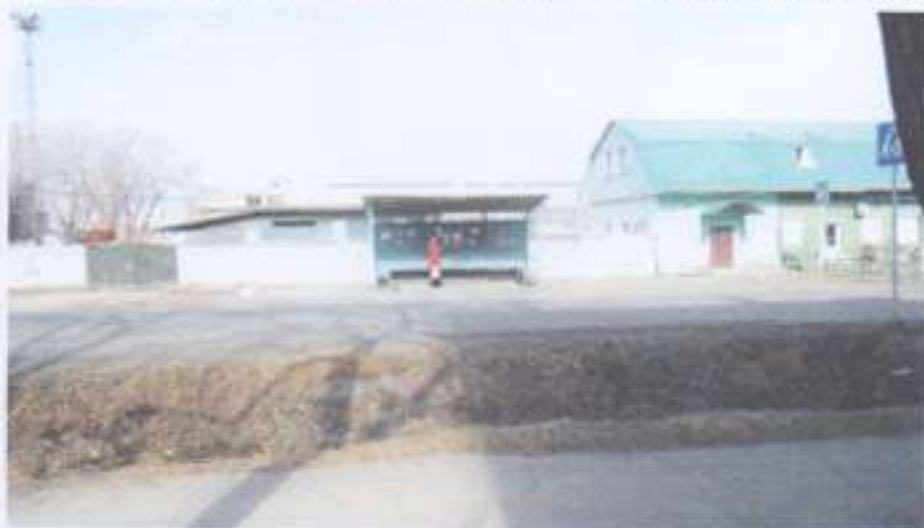
Фото № 18 (Пути движения к объекту (от остановки транспорта))
