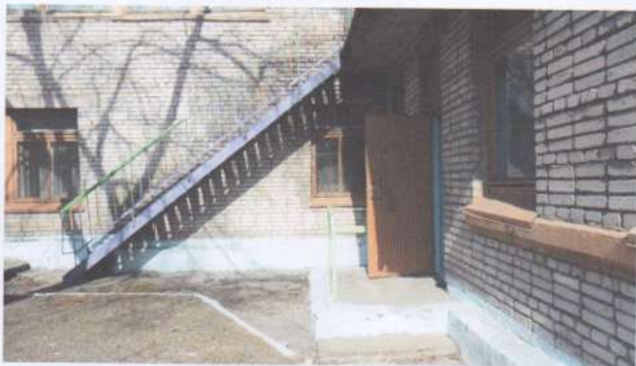
Фото № 9 (пути эвакуации)
