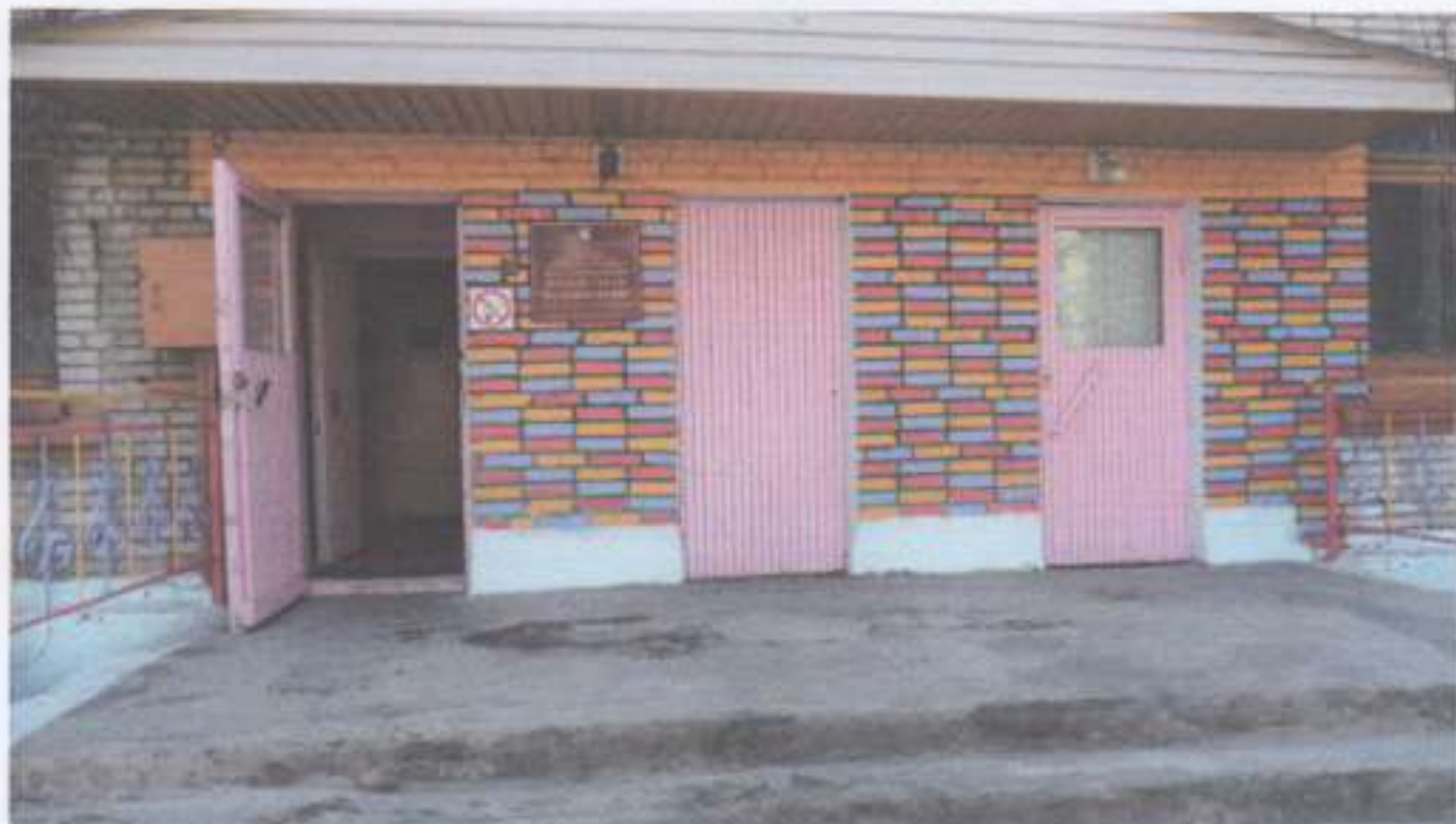
Фото №3а (входная площадка)
